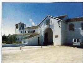
Fotografía 22 TEXTURA DE CUBIERTA: TEJA ÁRABE TEXTURA DE FACHADA: ENFOSCADO CON ACABADO RUGOSO
