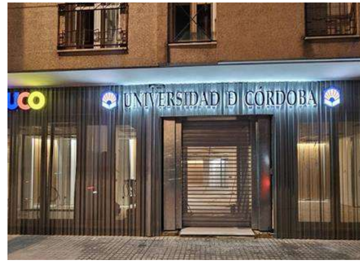
Finalizada la obra de adaptación del nuevo CENTRO DE ATENCIÓN AL ESTUDIANTE
